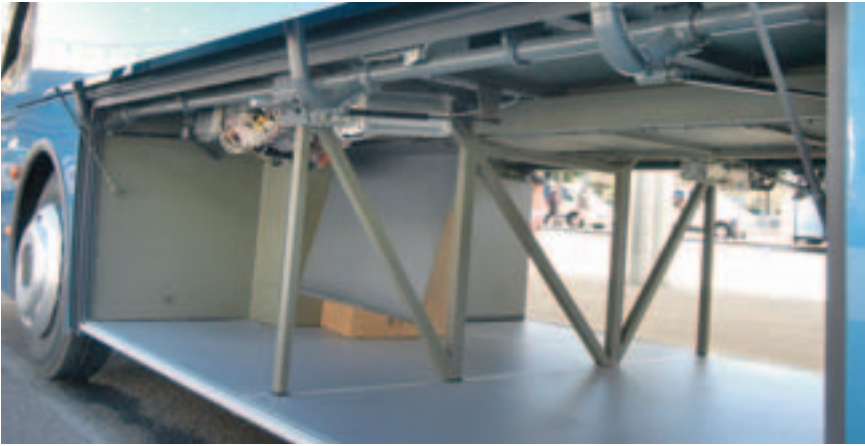
Großer Kofferraum mit sechs Kubikmetern, die Elektrozentrale für den Aufbau sitzt unter einer Klappe.
