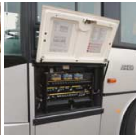
Ordentlich: E-Zentrale mit Dokumentation, aber leider am falschen Platz
