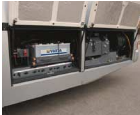
Saubere Installation im Heck – Nachfüllbehälter fürs Motoröl und die Lüfterhydraulik, Batterieschlitten mit Hauptschalter
