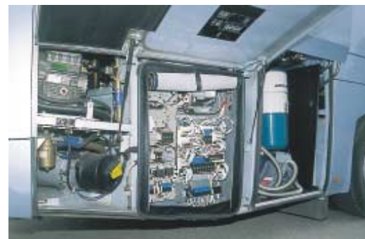
Hinter Reißverschlüssen staubfrei im Heck untergebracht: die Elektronik des Antriebs mit Steuergräten, Relais und Sicherungsautomaten.
